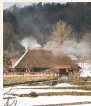
いぶした煙がかやぶき屋根を抜けて立ち上る
