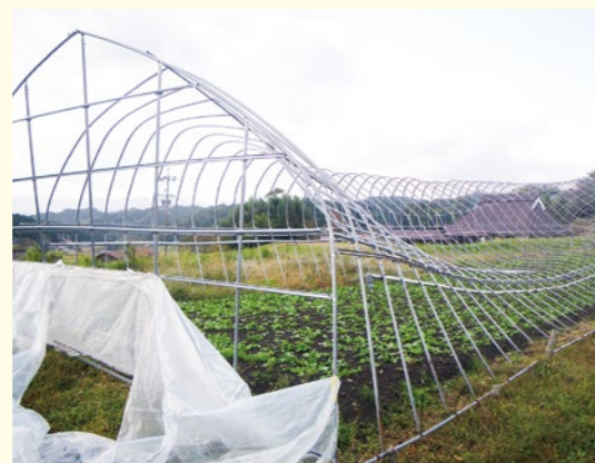
台風により変形したハウス
