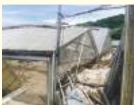
土砂で倒壊したハウス
