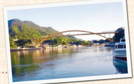
生口島と高根島を結ぶ高根大橋
